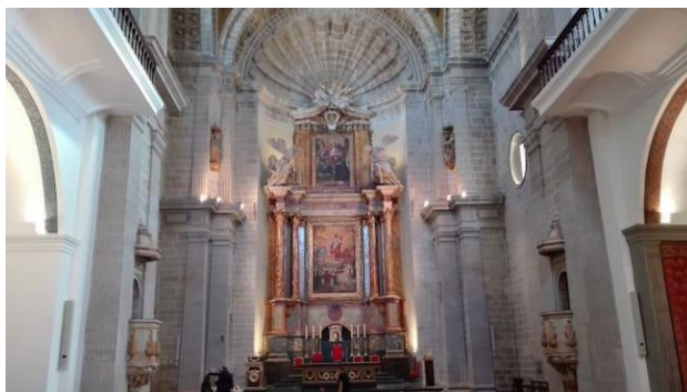
Рис. 2. Церковь Санта Каталина в Талавера де ла Рейна (Испания) после усиления (2018 г.)
