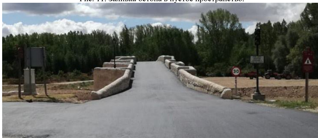
Рис. 12. Вид моста после осуществления процесса усиления-«оседлывания».
