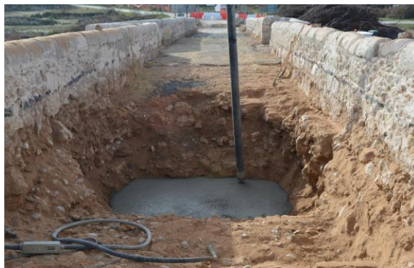
Рис. 11. Заливка бетона в пустое пространство.
