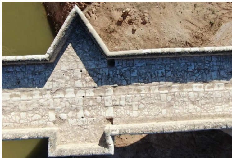
Рис. 9. Оригинальное дорожное покрытие – брусчатка, вскрытое под верхним слоем дорожной одежды.
