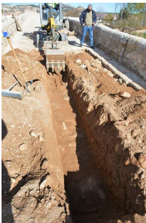
Рис. 10. Откопка центральной траншеи для дальнейшего заполнения бетоном.
