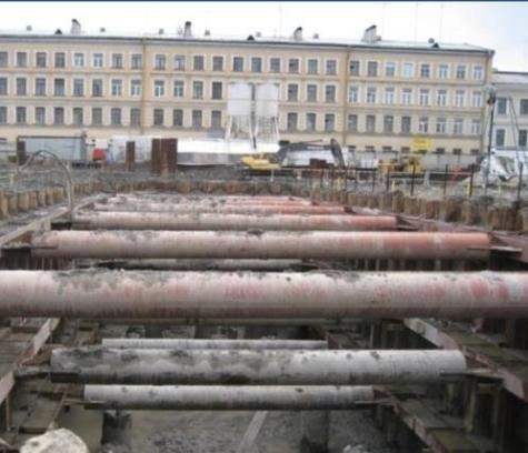
**Устройство глубоких котлованов в условиях плотной застройки на слабых грунтах**
