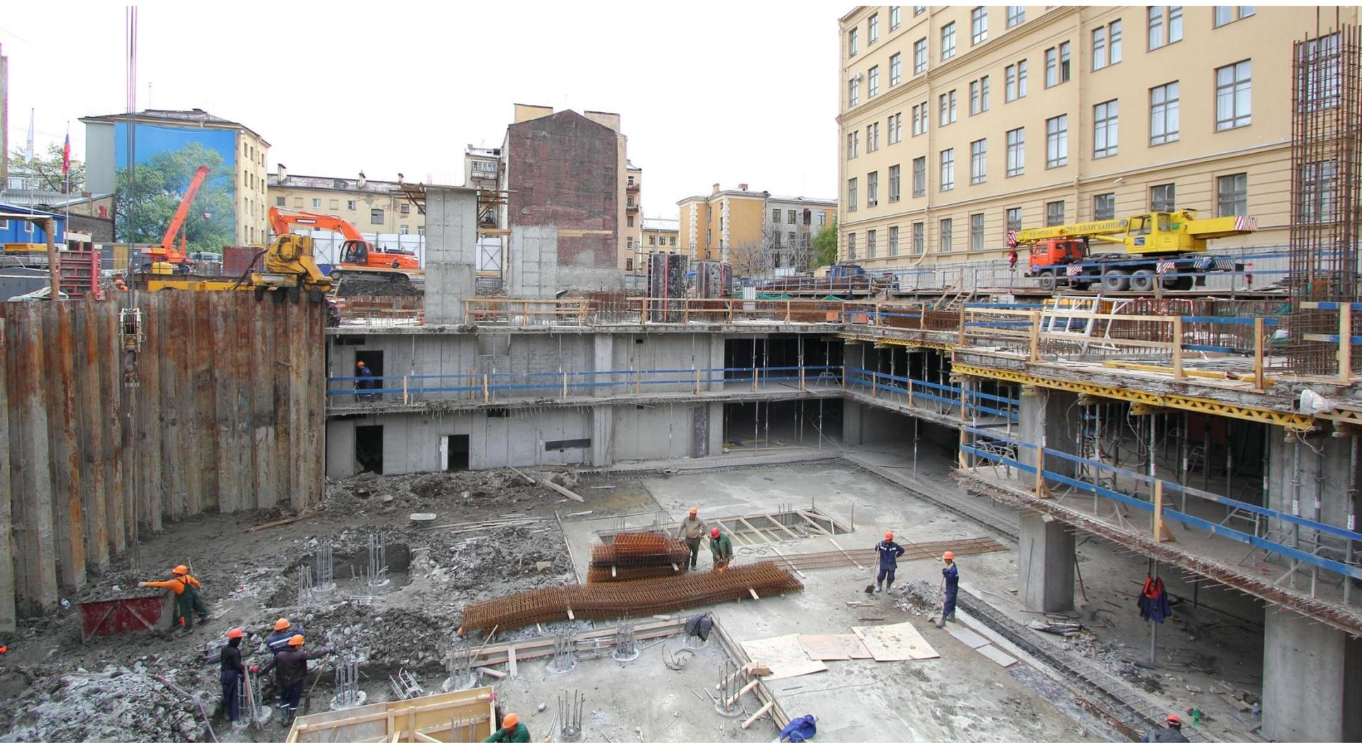
Струйная технология позволяет реализовать эффективный способ устройства подземного сооружения в плотной городской застройке с коротким шпунтовым ограждением (способ «жесткий контур»)
