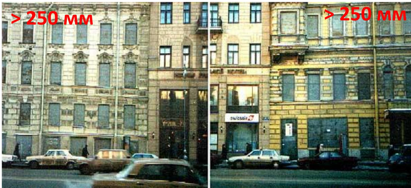
Разрушение зданий при строительстве подземного сооружения гостиницы «Невский Палас»
