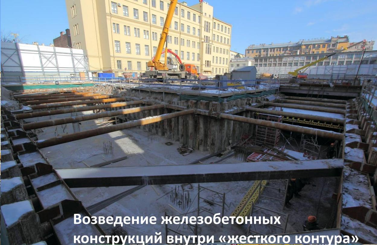
Возведение железобетонных конструкций внутри «жесткого контура»
