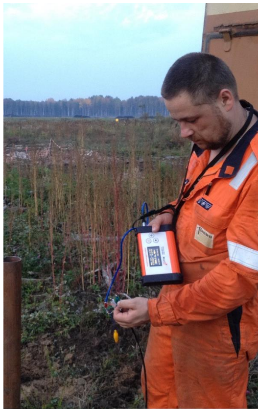
Мониторинг порового давления в грунте
