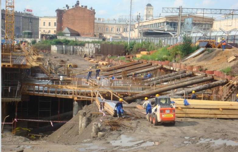
Подкосы и распорные конструкции
