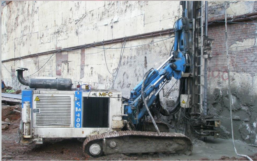
Закрепление грунтов основания по технологии Jet-grouting
