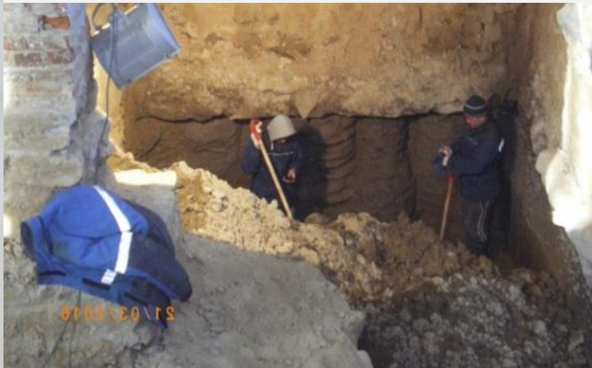
Закрепление грунтов основания по технологии Jet-grouting
