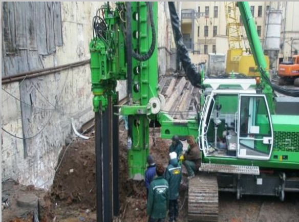
Вдавливание металлического шпунта
