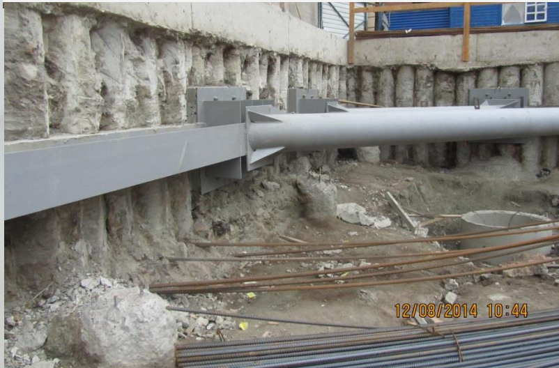
Подкосы и распорные конструкции
