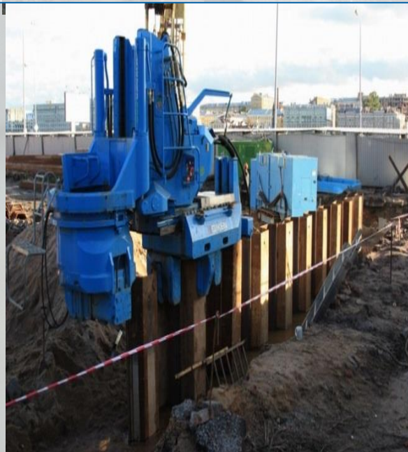
Вдавливание металлического шпунта
