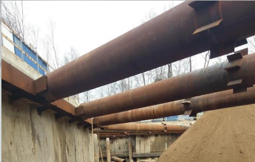
Конструкция «стена в грунте», устраиваемая при помощи гидравлического грейфера
