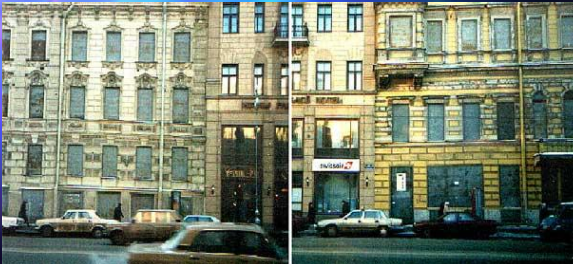
Деформация соседних исторических зданий при освоении подземного пространства под гостиницей «Невский Палас» по адресу: Невский проспект, 57
