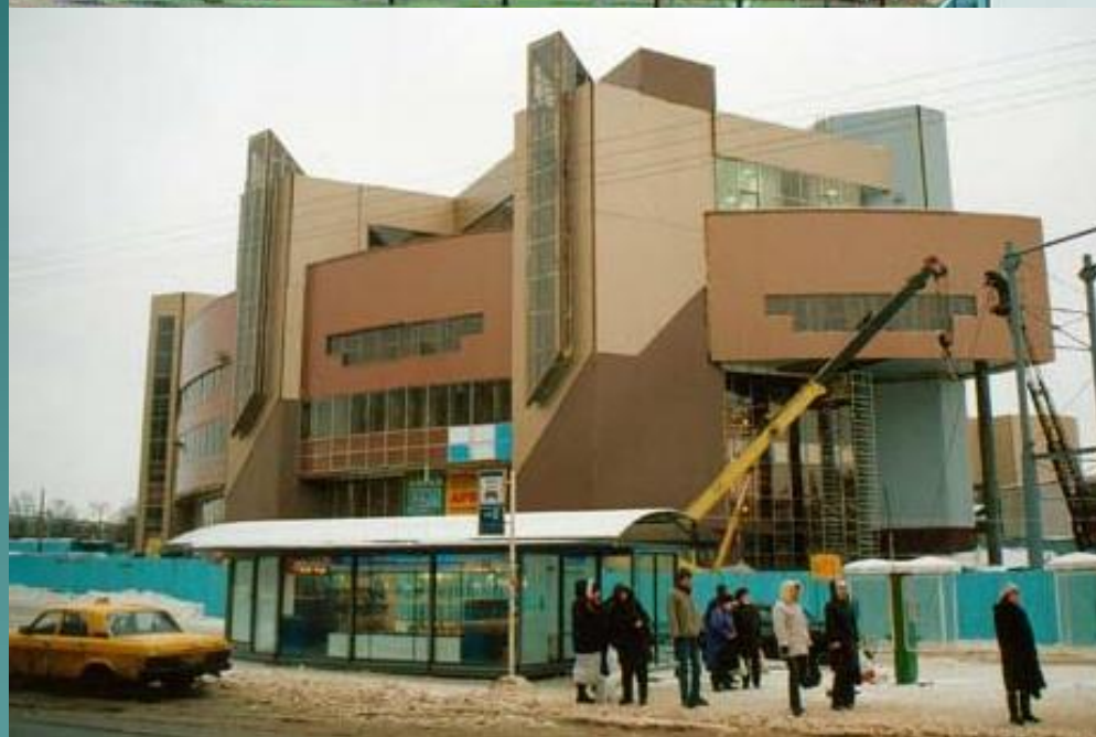
Строительство торгово-бытового комплекса в кв. 12 Шувалово-Озерки Выборгского района г. Санкт-Петербурга у вестибюля станции метро “Озерки”.
