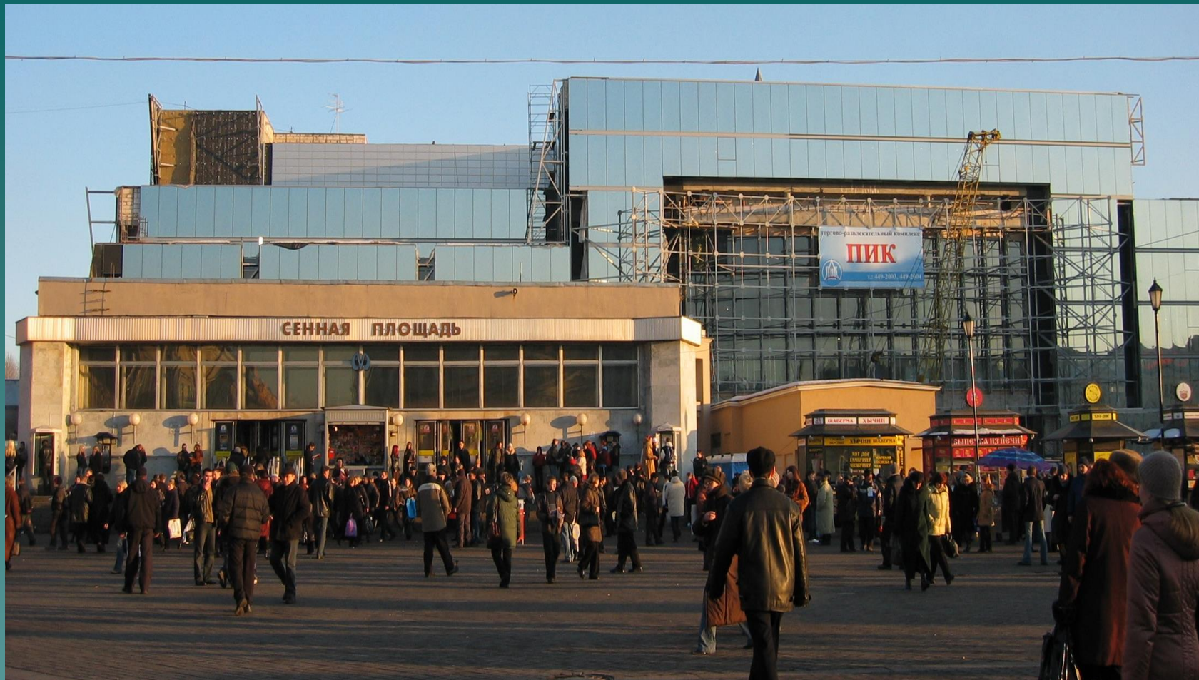
Строительство коммерческого центра у вестибюля станции метро “Сенная площадь”.
