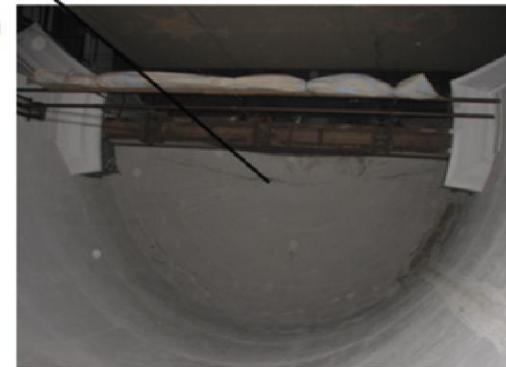
10. Места возможного возникновения трещин (главные нормальные напряжения превышают прочностные на растяжение). Вид снизу.
