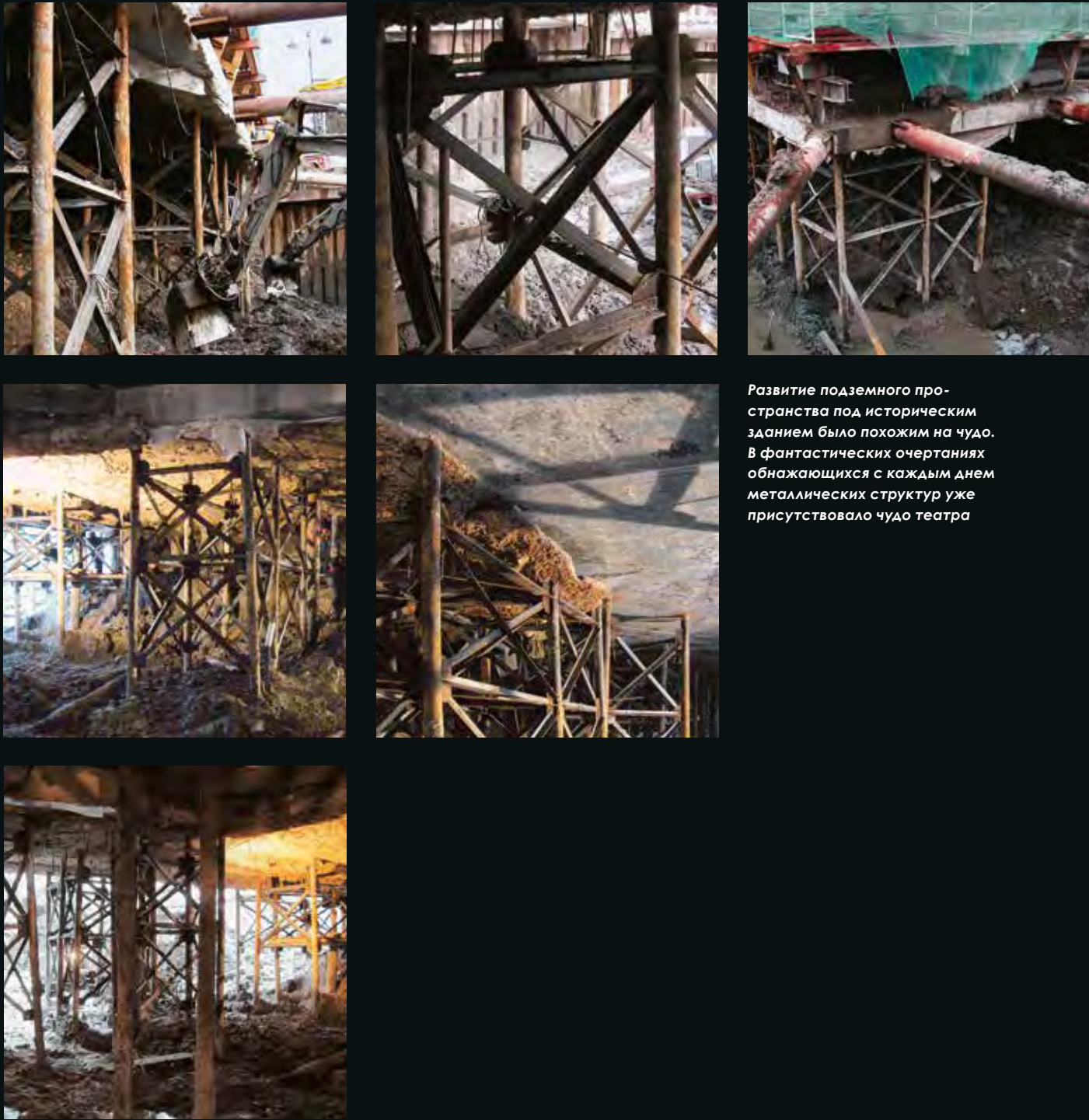
СВАИ ПОД ЗДАНИЕМ ТЕАТРА, ОБЪЕДИНЕННЫЕ РАСКОСАМИ В СКВОЗНЫЕ КОЛОННЫ
