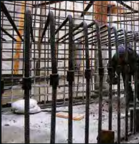
Армирование плиты дна завершено. Теперь можно приступить к ее бетонированию. Плита станет постоянным ростверком для свай, на которых держится историческое здание
