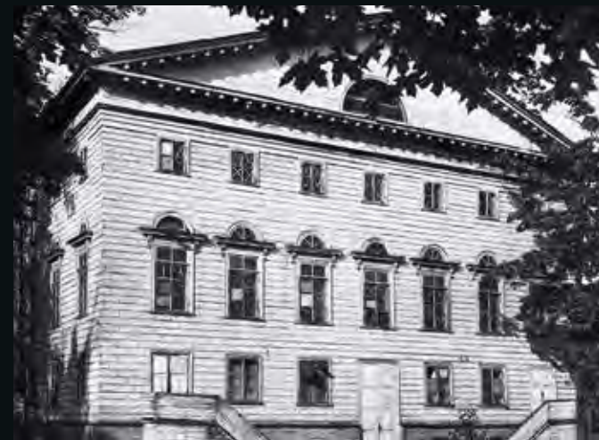
Задний торцевой фасад театра. Октябрь 1950 г. Негатив КГИОП
