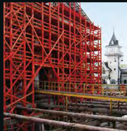
УСТРОЙСТВО МОНОЛИТНОГО ЖЕЛЕЗОБЕТОННОГО ПОКРЫТИЯ ПОДЗЕМНОЙ ЧАСТИ ТЕАТРА (ПЕРЕД ГЛАВНЫМ ФАСАДОМ)
