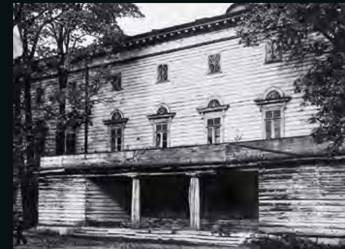
Вид боковых крылец-пристроек, выполненных по проекту Е. Катонина в 1932 г.
