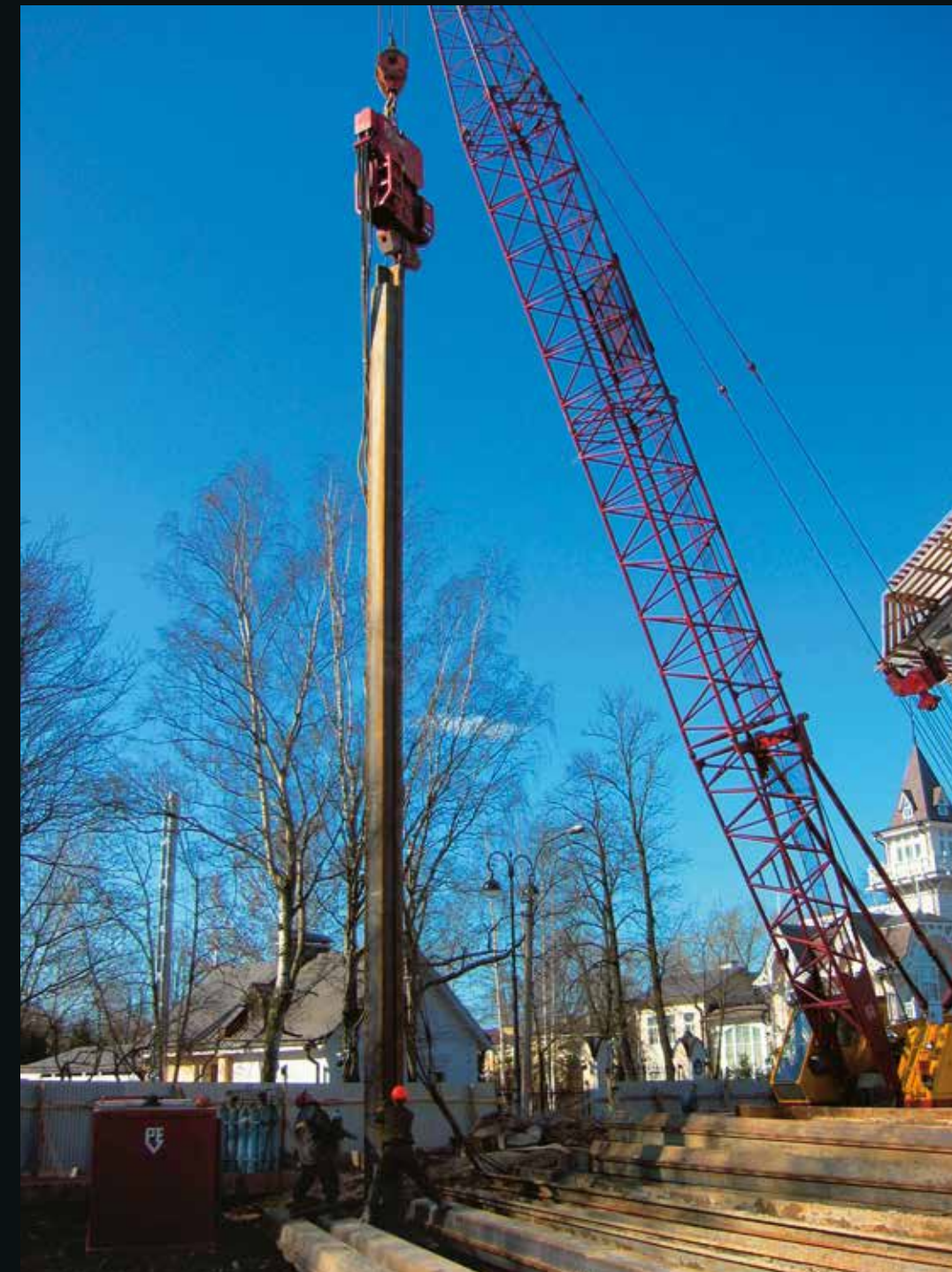
Вибропогружение шпунта при устройстве ограждения котлована
