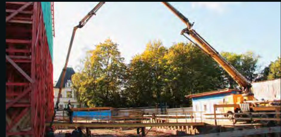
УСТРОЙСТВО МОНОЛИТНОГО ЖЕЛЕЗОБЕТОННОГО ПОКРЫТИЯ ПОДЗЕМНОЙ ЧАСТИ ТЕАТРА (ПЕРЕД ГЛАВНЫМ ФАСАДОМ)
