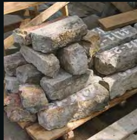
Цоколь здания, выполненный из путиловского известняка, был пронумерован, демонтирован, очищен от повреждений и установлен на свое место
