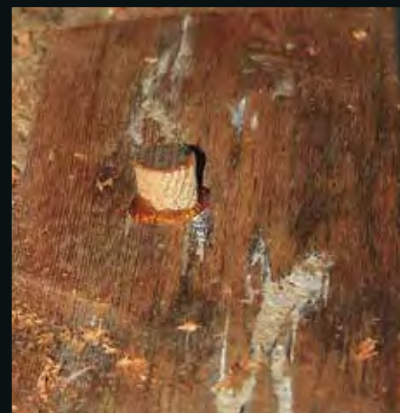
Дощатая облицовка наруж- ных стен (декорированная под камень) бережно снималась, при этом извлекался и реставри- ровался каждый кованый гвоздь. Отверстия в досках тщательно заделывались деревянными пробками на клею
