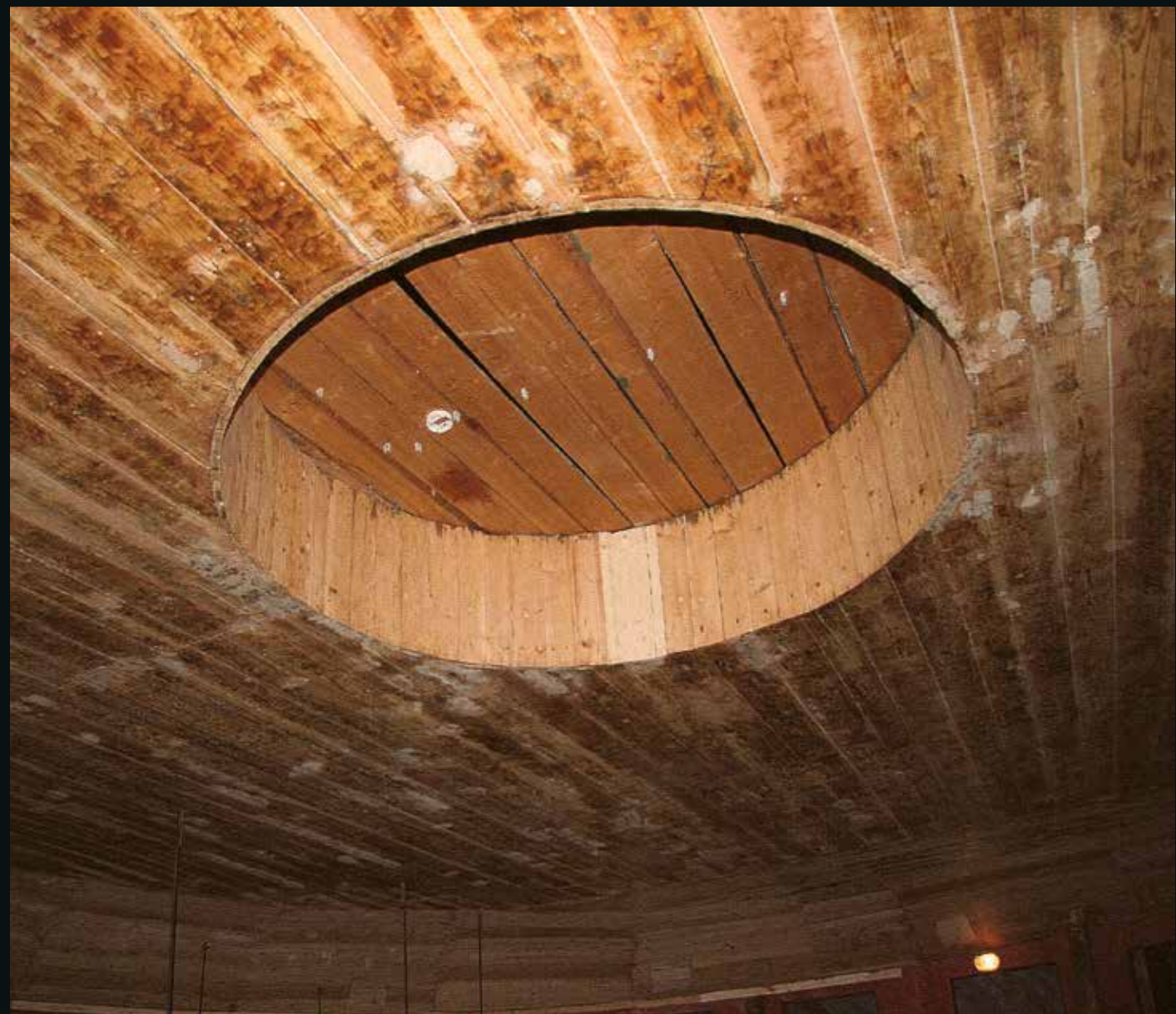
Реставрация подвесного потолка зрительного зала, выполненного без использования пилы и рубанка из тесаных досок, соединенных между собой на столярных клеях. Потолок образует своеобразную деку, обеспечивающую уникальную акустику зрительного зала
