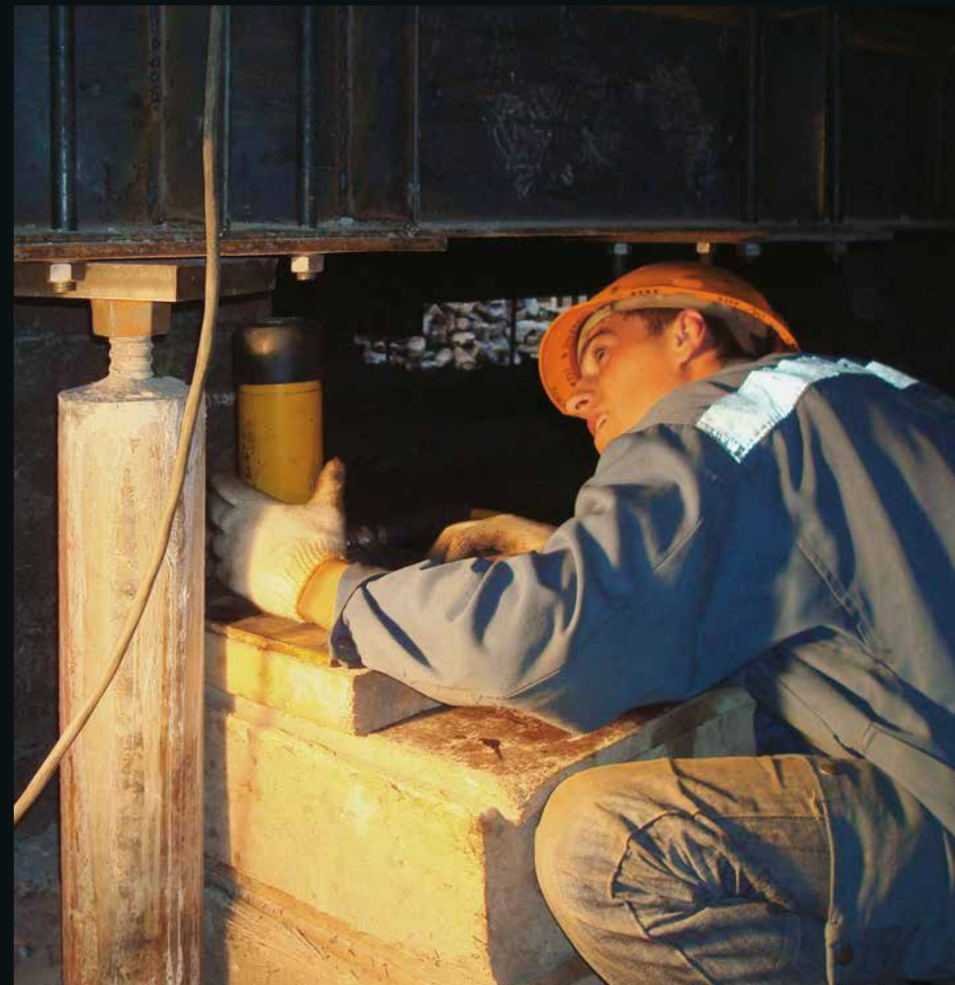
Поддомкрачивание обвязочного пояса для передачи нагрузки от исторического здания на сваи
