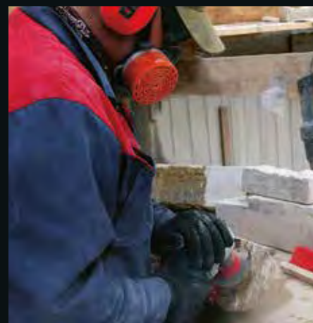
Цоколь здания, выполненный из путиловского известняка, был пронумерован, демонтирован, очищен от повреждений и установлен на свое место
