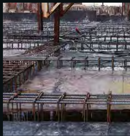
Подземное пространство вокруг театра постепенно одевалось железобетонным покрытием, по которому предстояло уложить слой уте- плителя и устроить мостовую площади перед театром
