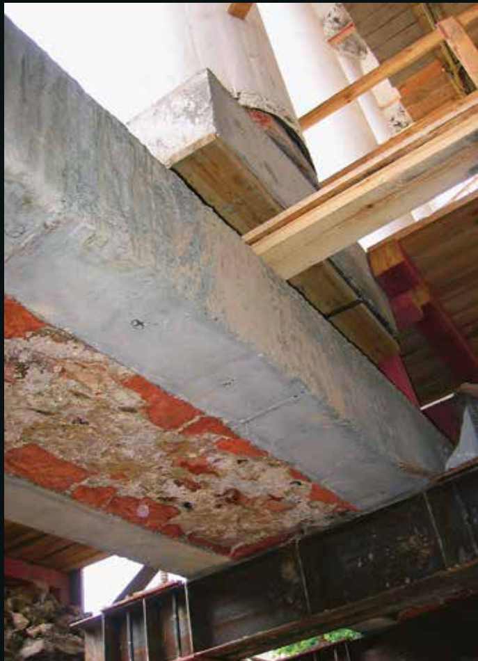
Вид на портик театра из-под подошвы фундамента, пересаженного на сваи. Возможно, что именно с этой точки зрения смотрит геотехник на архитектуру
