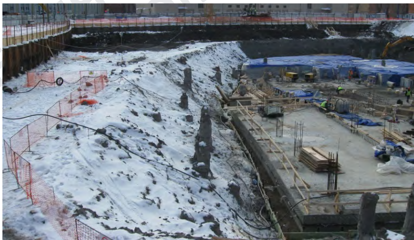
Откопка котлована с откосами.
