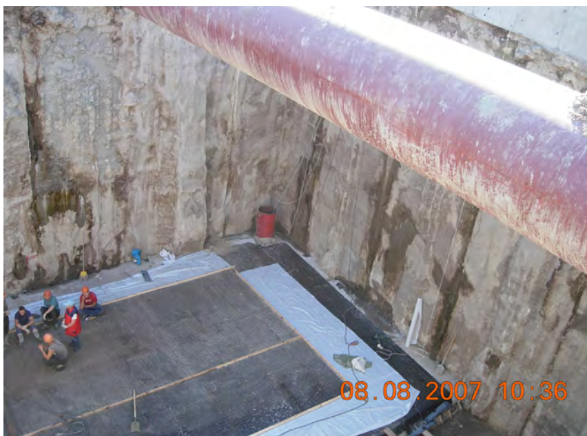
Первый в Петербурге удачный опыт устройства котлована под защитой стены в грунте на строительстве участков Орловского тоннеля.
