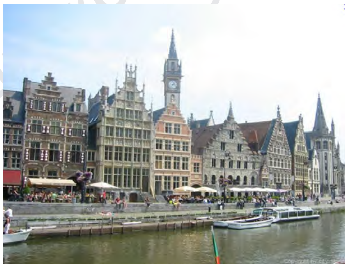
Реконструкция исторических зданий в Генте (Бельгия): за сохраненными фасадами устроено многоуровневое подземное пространство и комфортабельная гостиница с ресторанами.
