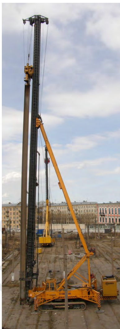
Вибропогружение шпунта рекордной длины.
