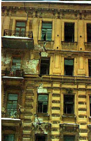
Примеры разрушения исторической застройки при устройстве подземных объемов для гостиницы «Невский Палас» на Невском пр. и жилого дома на Мичуринской ул.
