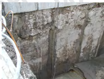
Примеры устройства ограждения котлована: из шпунта (слева) и методом «стена в грунте» (справа).
