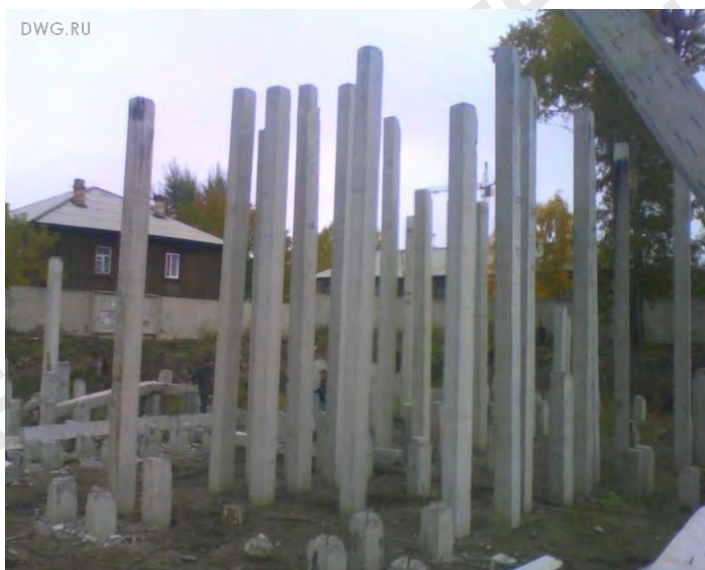
Свайный лес вместо свайного поля.
