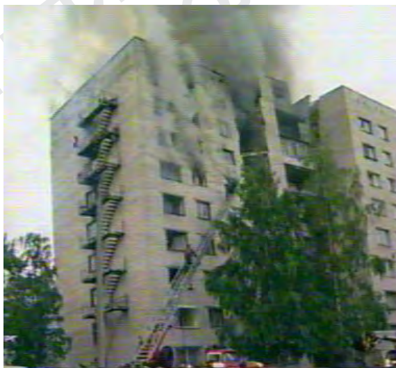
Дом на Двинской ул. перед обрушением.
