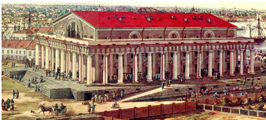
Здание Биржи на момент завершения строительства.
