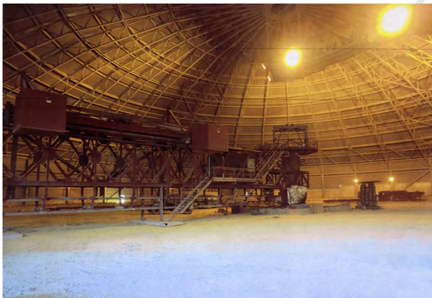
Склад клинкера: купол диаметром 100 м.
