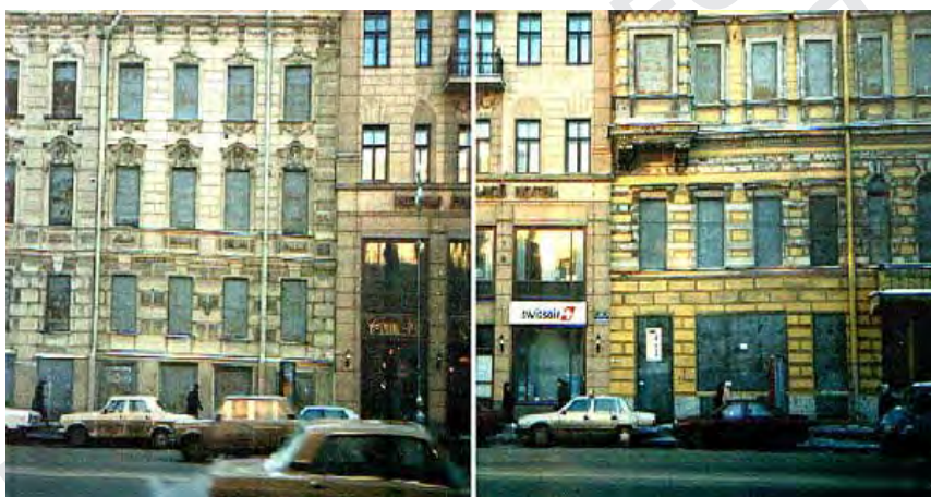
Примеры разрушения исторической застройки при устройстве подземных объемов для гостиницы «Невский Палас» на Невском пр. и жилого дома на Мичуринской ул.
