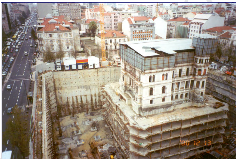
А.Пинто: строительство подземного объема вокруг исторического здания в Португалии.
