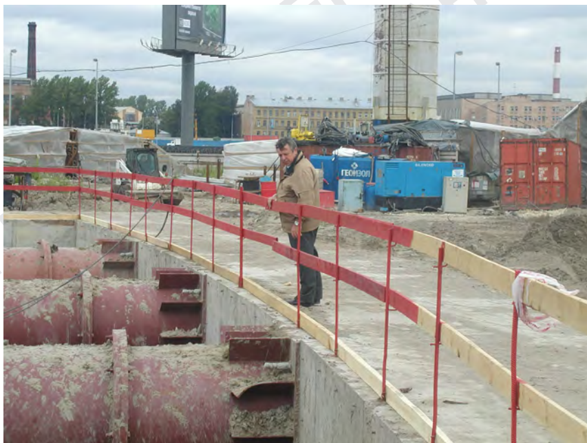
Фрагмент ramпы Орловского тоннеля – первый подземный объект в Санкт-Петербурге, успешно выполненный с использованием современной технологии «стена в грунте».
