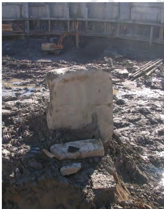
Первая попытка выполнить стену в грунте по современной технологии («Franki», «Геозол», Комендантская пл.).
