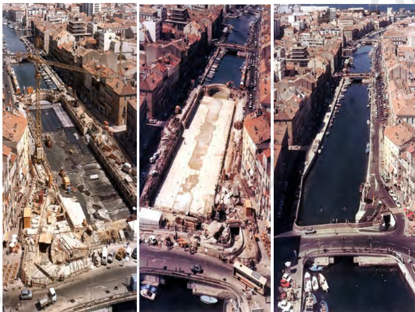
Soletanche-Bachy: устройство двухэтажного паркинга ниже дна реки в историческом городе Франции; слева направо: устройство гидроизоляции перекрытия паркинга (вода реки временно пущена через трубу); укладка защитных плит – искусственного дна реки; строительство завершено, о нем напоминают только въездные порталы паркинга.
