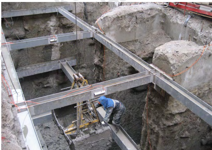
Зоологический пер. Первый опыт устройства стены в грунте в близком примыкании к существующим зданиям (эксперимент проводился на зданиях, подлежащих разборке).
