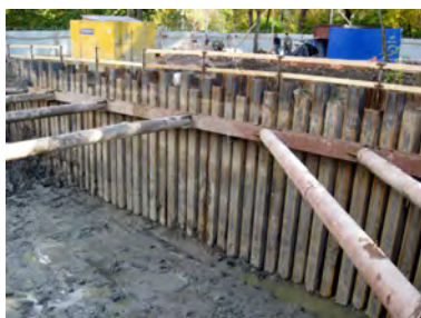
Примеры устройства ограждения котлована: из шпунта (слева) и методом «стена в грунте» (справа).
