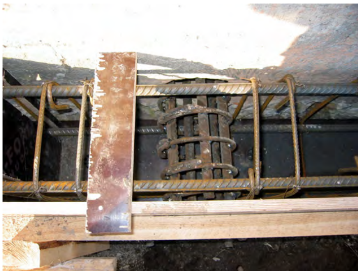
Армирование обвязочного пояса.
