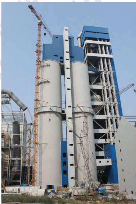
Расчетная схема конструкций силосов и возведенные конструкции промышленного небоскреба: 130-метрового «холодного конца печи» и силосов высотой 80 м.
