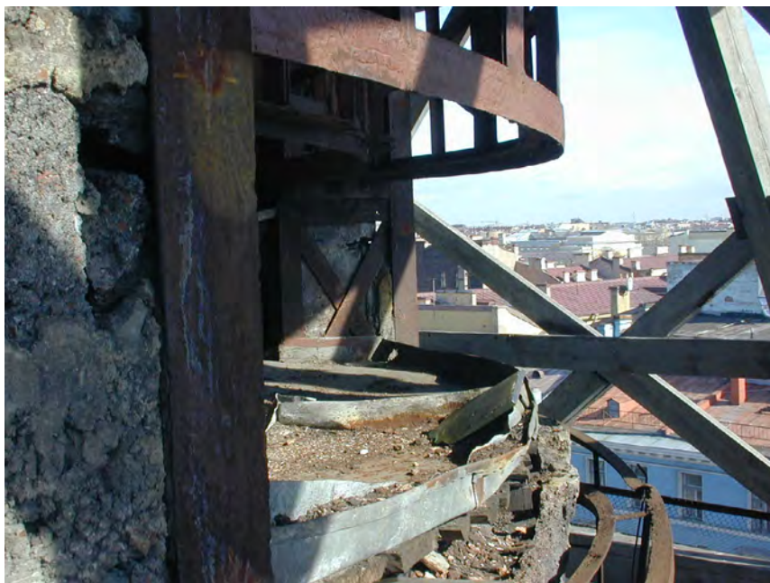
Металлокирпичные конструкции «Дома Книги».
