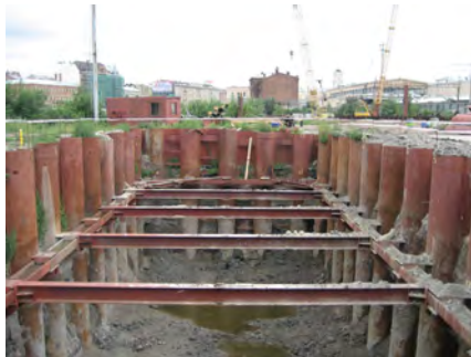
Опытные площадки по устройству глубоких котлованов на территории Санкт-Петербурга с подробным мониторингом поведения грунта
